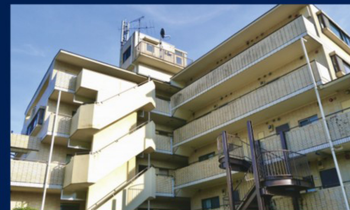
■ 習志野市：一棟マンション
